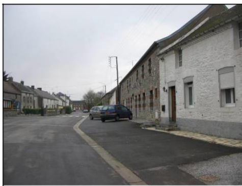
Face à la mairie l'espace mal défini est utilisé comme stationnement
