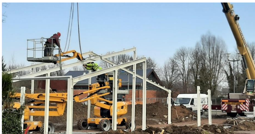
Montage de la charpente
