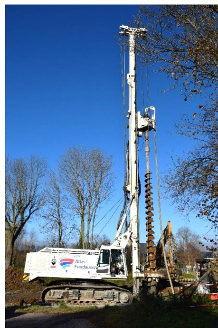
La machine qui a foré les pieux
