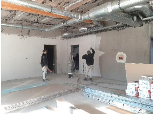
Les enduits sont en cours
